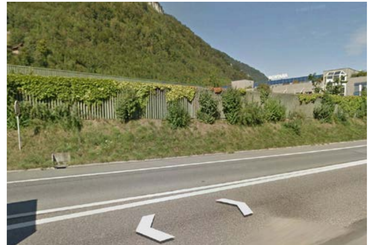
Figura 4.28 Pantalla acústica de metal perforado.
