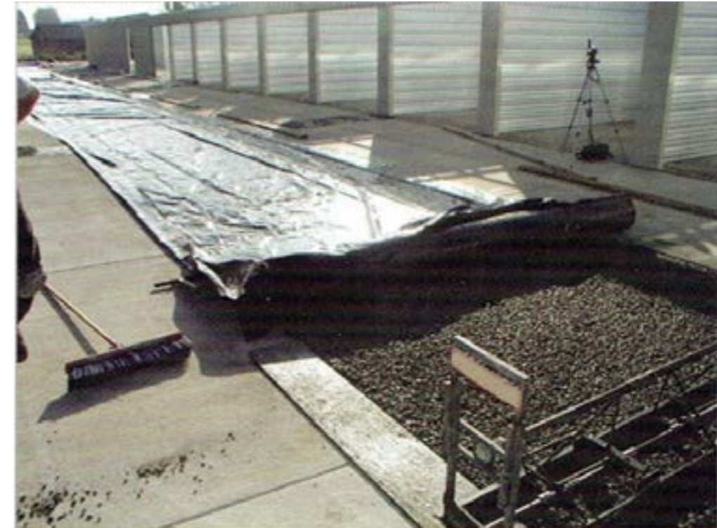
Figura 4.38 Instalación de pliegos o láminas de plástico para cubrir el concreto permeable dentro de los primeros minutos después de su consolidación, para así evitar pérdida de agua por evaporación.
