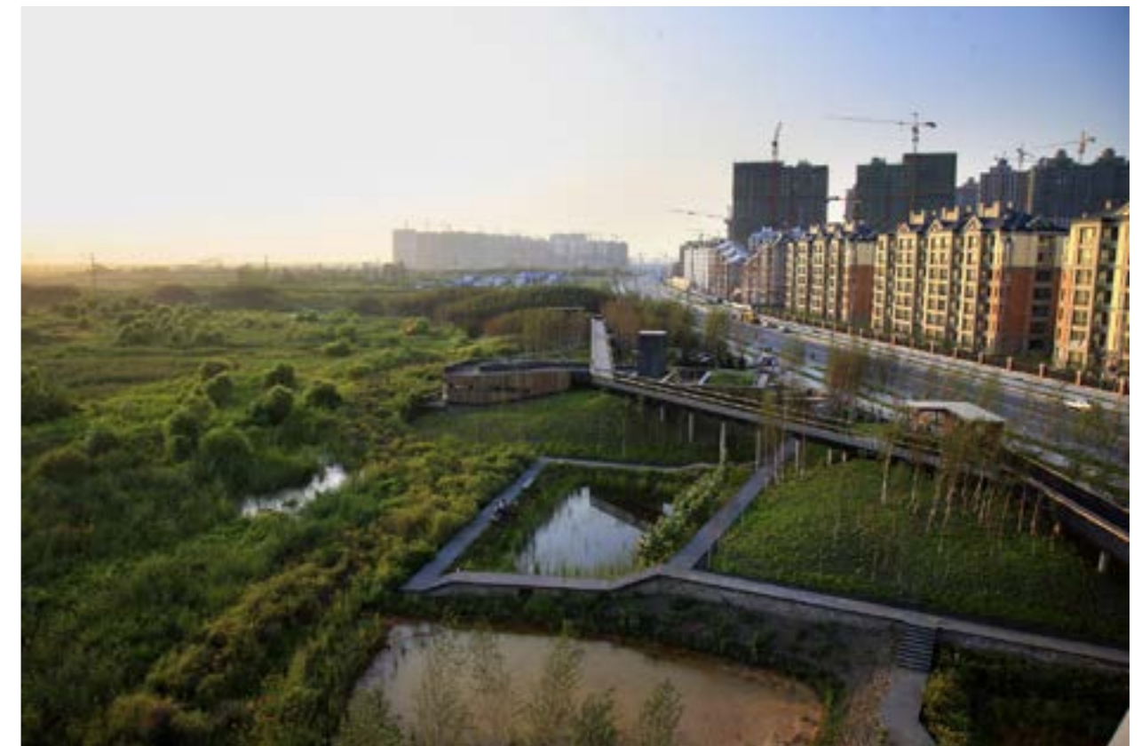
Figura 3.20 Cuenca de retención a un costado de la carretera, Qunli, China.
