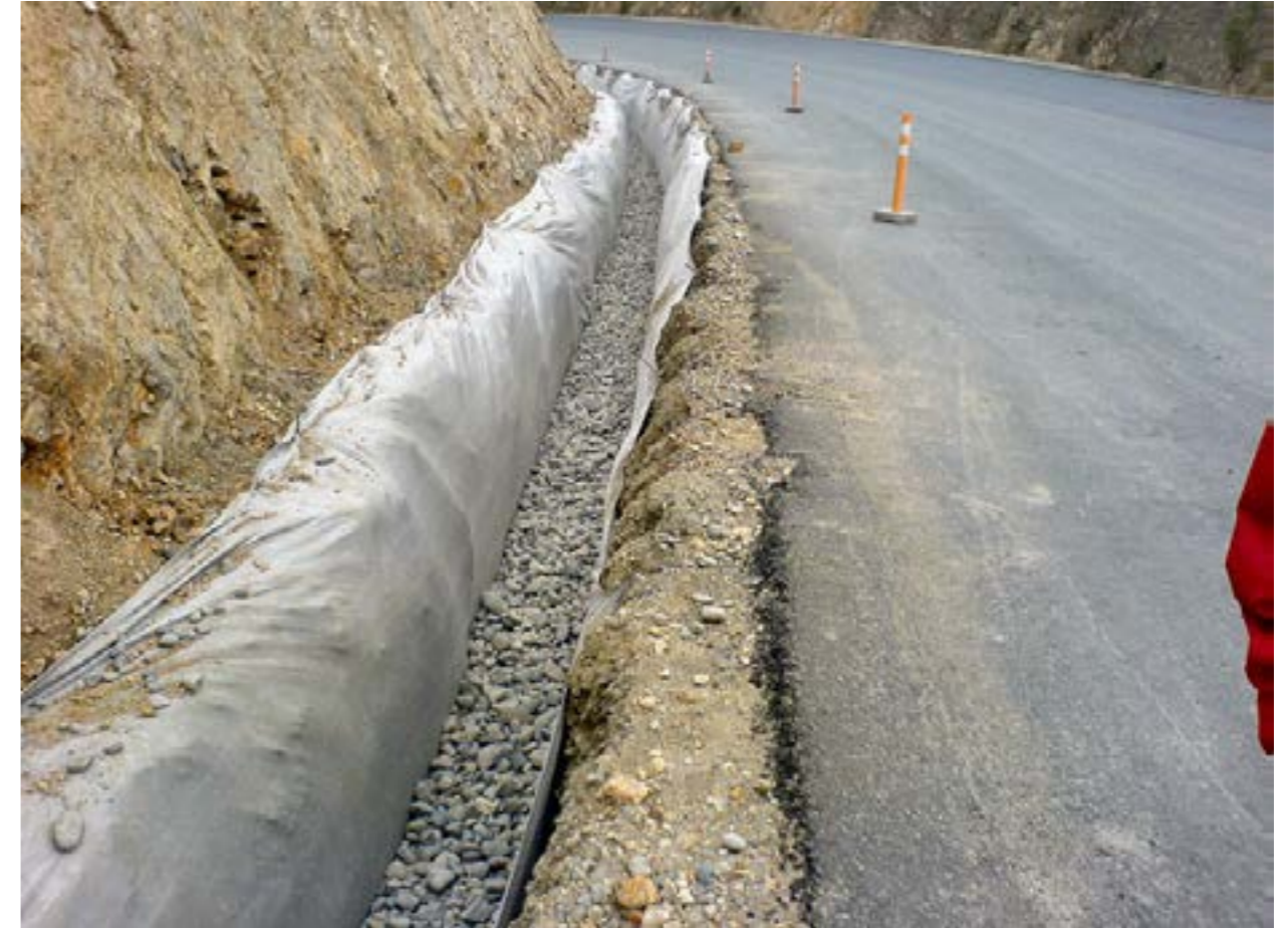
Figura 10 Construcción del subdren longitudinal.
