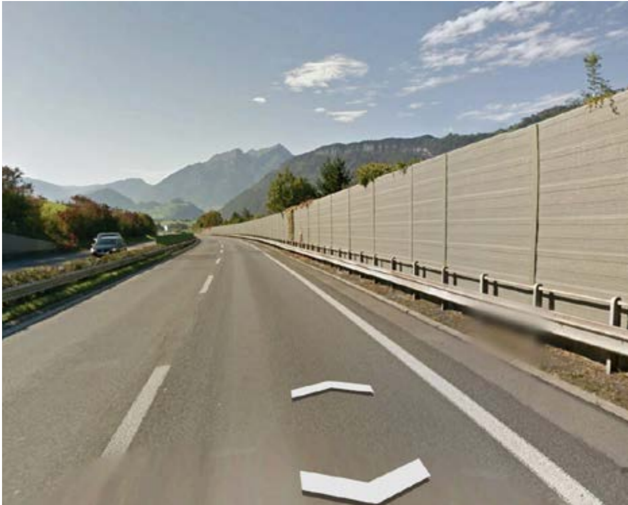
Figura 4.27 Pantalla de concreto con fibras de madera.
