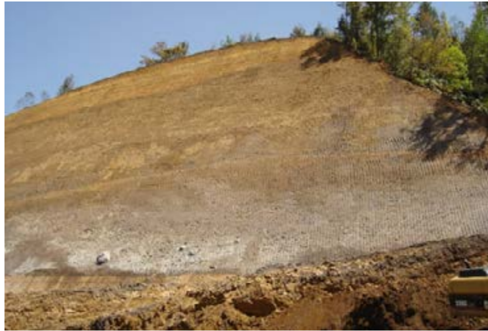
Figura 3.10 Ejemplo de estabilización de un corte a partir de terrazas y revegetación con tulias. Autopista México-Tuxpan, tramo Tejocotal-Nuevo Necaxa.
