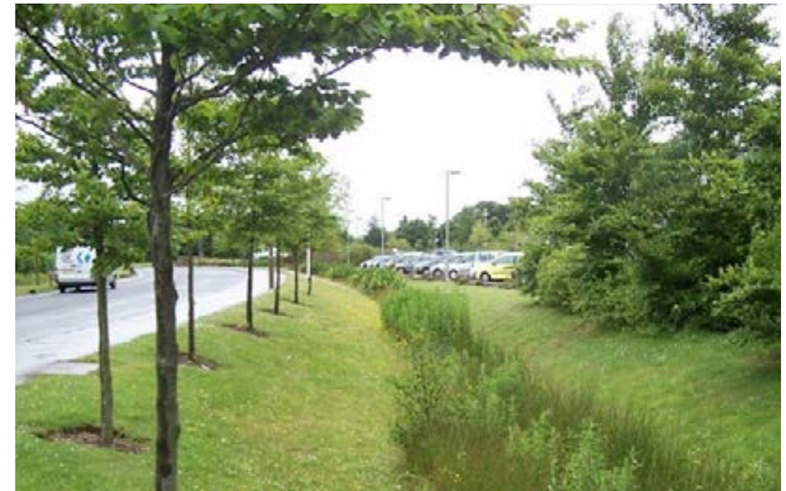
Figura 3.15 Cuneta húmeda con césped y plantas resistentes a inundaciones.
