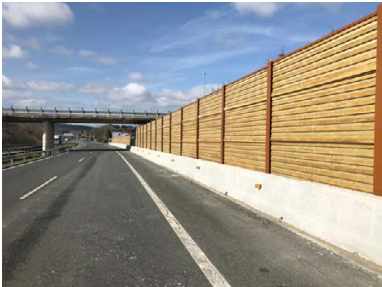
Figura 4.29 Pantalla acústica de madera.
