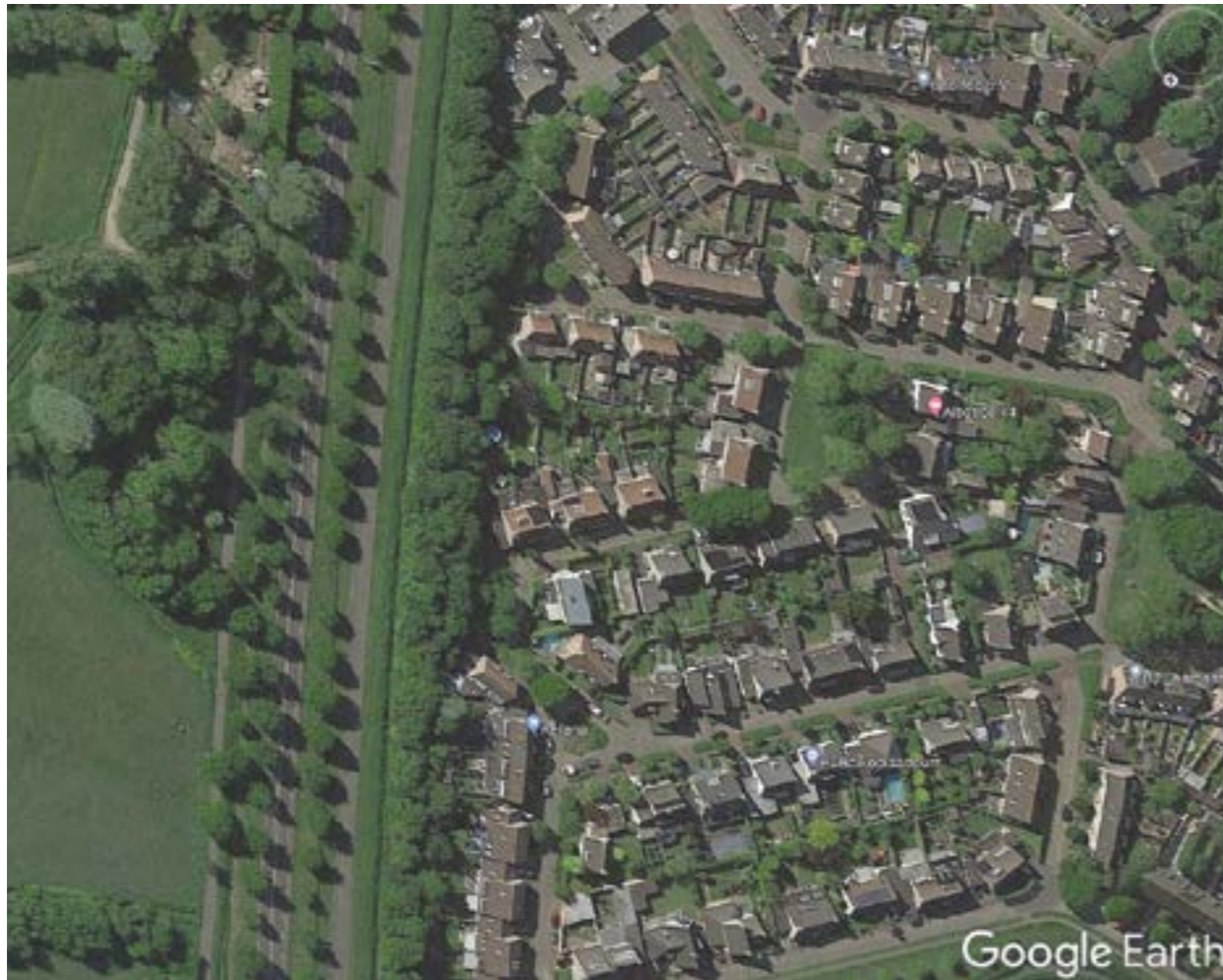
Figura 1.9 Barrera natural anti ruido en carretera de Holanda.
