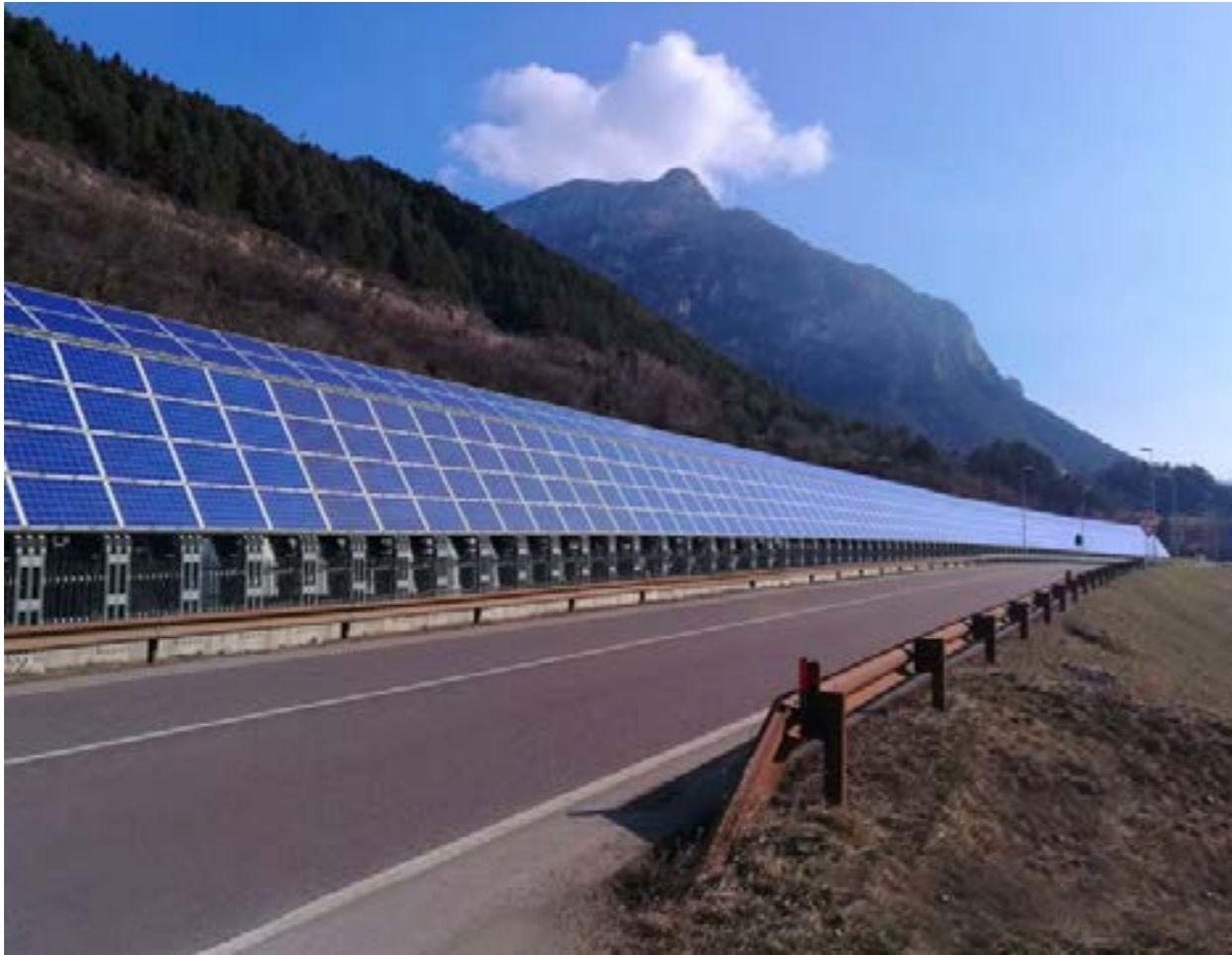
Figura 3 Ejemplo del uso de paneles solares para la iluminación y suministro de electricidad en carreteras de Italia.
