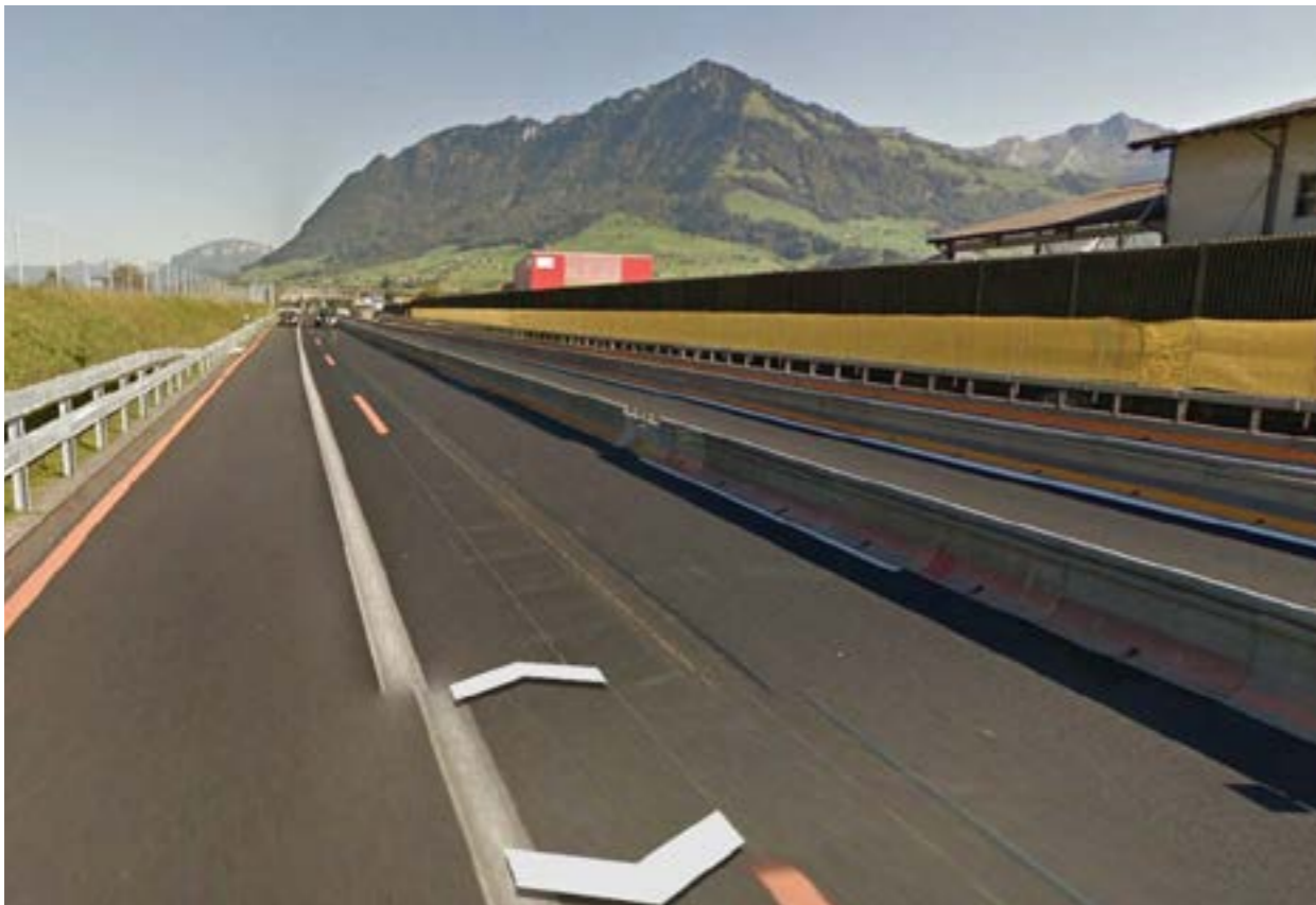
Figura 3.26 Barreras protectoras de sonido en autopista de Suiza. A la izquierda, barrera con montículos de tierra; a la derecha, con láminas de acero.
