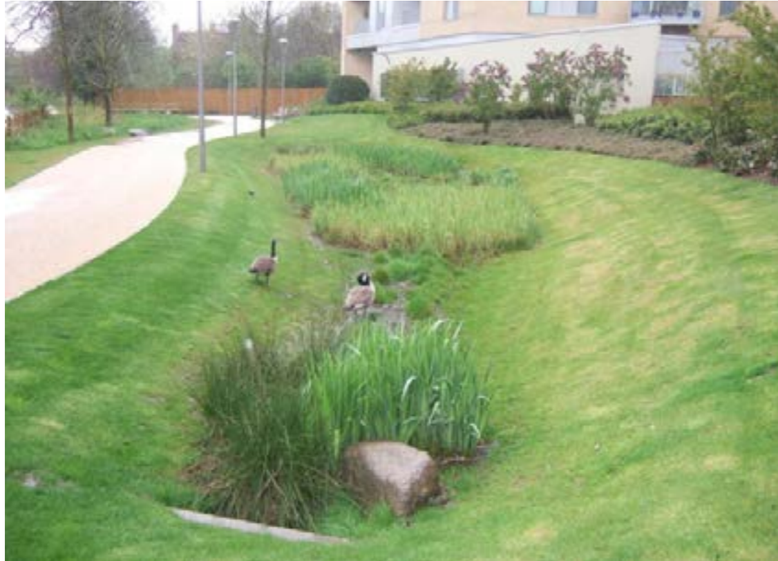
Figura 3.14 Cuneta seca con césped y plantas perennes.
