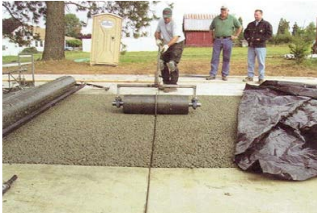
Figura 4.37 Rodillo usado para hacer juntas, comúnmente llamado pizza cutter .
