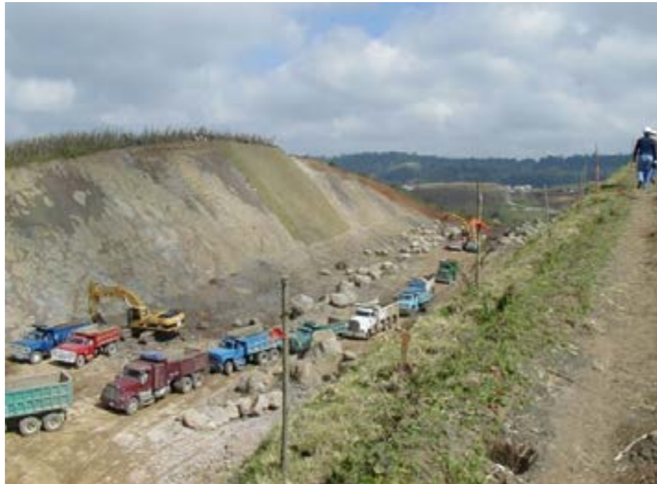
Figura 27 Ejemplo de un corte revegetado con pasto tipo alfombra. Autopista México-Tuxpan, tramo Tejocotal-Nuevo Necaxa.
