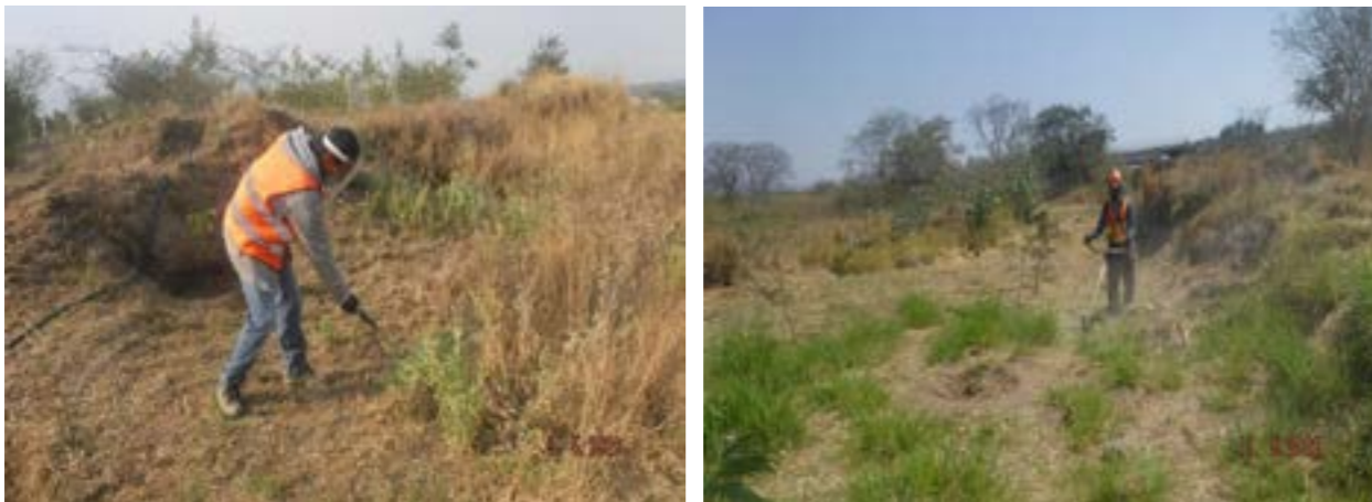
Figura 77 Ejemplo de deshierbe por mantenimiento.
