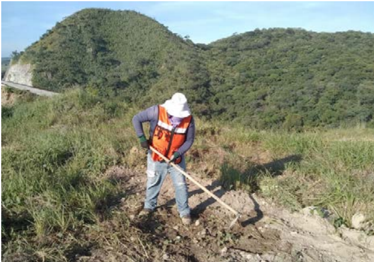
Figura 50 Apertura de brecha cortafuego.
