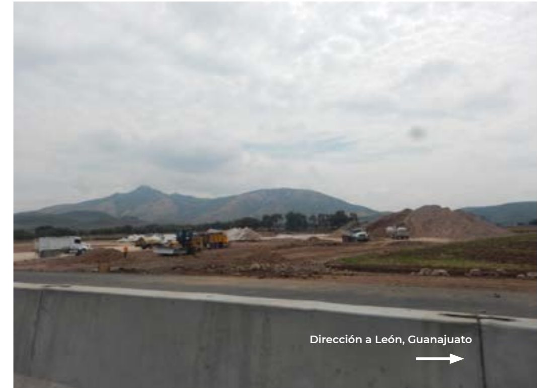
Figura 16 Banco de material. Libramiento de Silao, en el estado de Guanajuato.
