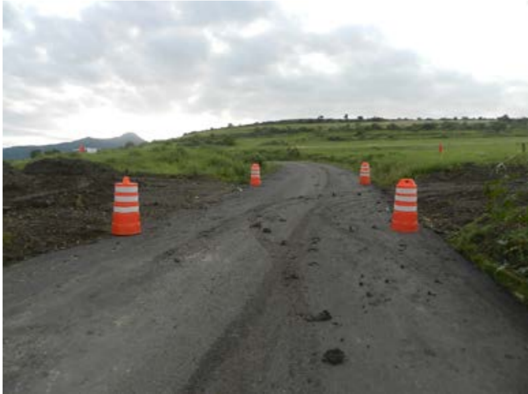
Figura 15 Camino de acceso habilitado para llegar al frente de trabajo. Autopista Silao, en el estado de Guanajuato.
